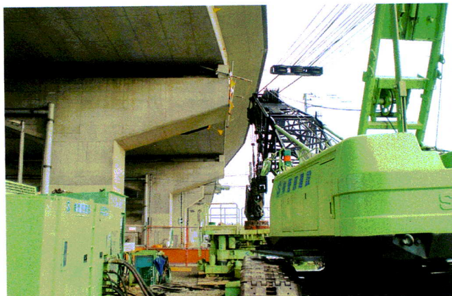
油圧式ハンマーグラブを使用した高架下での基礎工事
