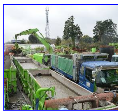
JSR拡底掘削状況
