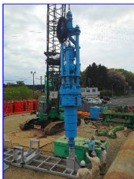
JSRリバース掘削機
