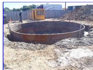
ライナープレート設置・掘削
