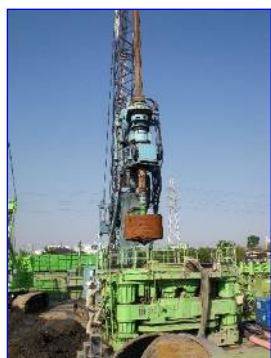
アースドリル工法
