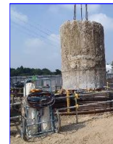
1断面目 引上げ
